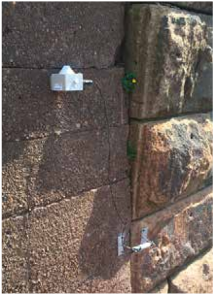
Bild 3: 1D-Cracksensor, angeschlossen an einen drahtlosen Datenknoten
