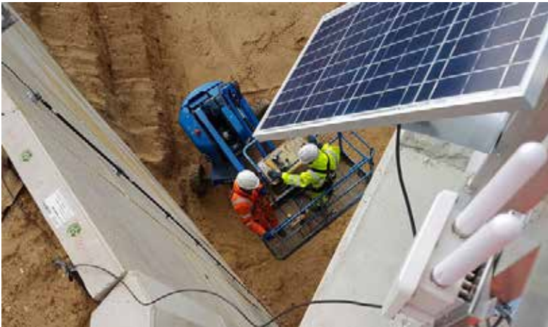
Bild 11: MEMS-Neigungssensorik, implementiert in Carbonfaser-Stäbe, hier als Kette montiert zur Bestimmung von Bauwerksdeformationen
