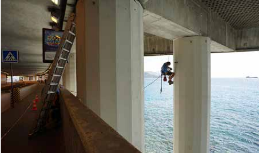
Bild 9: Installation von Neigungssensoren an der Formel-Eins-Rennstrecke in Monte Carlo durch „angelerntes“ Personal
