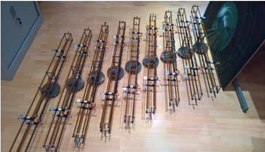
Bild 15: Vorgefertigte Bewehrungskörbe mit montierten Strain-Sensoren und implementiertem Gehäuse für die 4-Kanal-VW-Node
